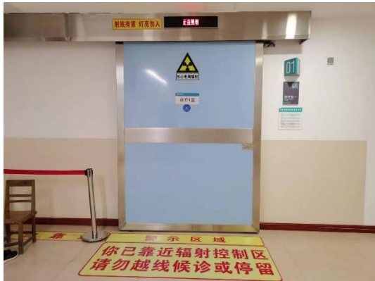
图 3-3 机房防护门（正在照射状态）
