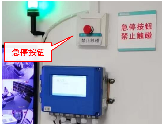
图 3-7 控制室内固定式辐射仪显示单元
