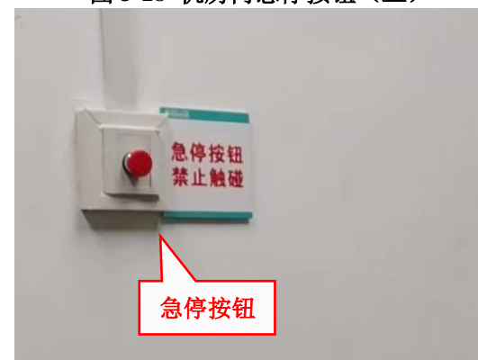
图 3-20 机架室后墙急停按钮（五）
